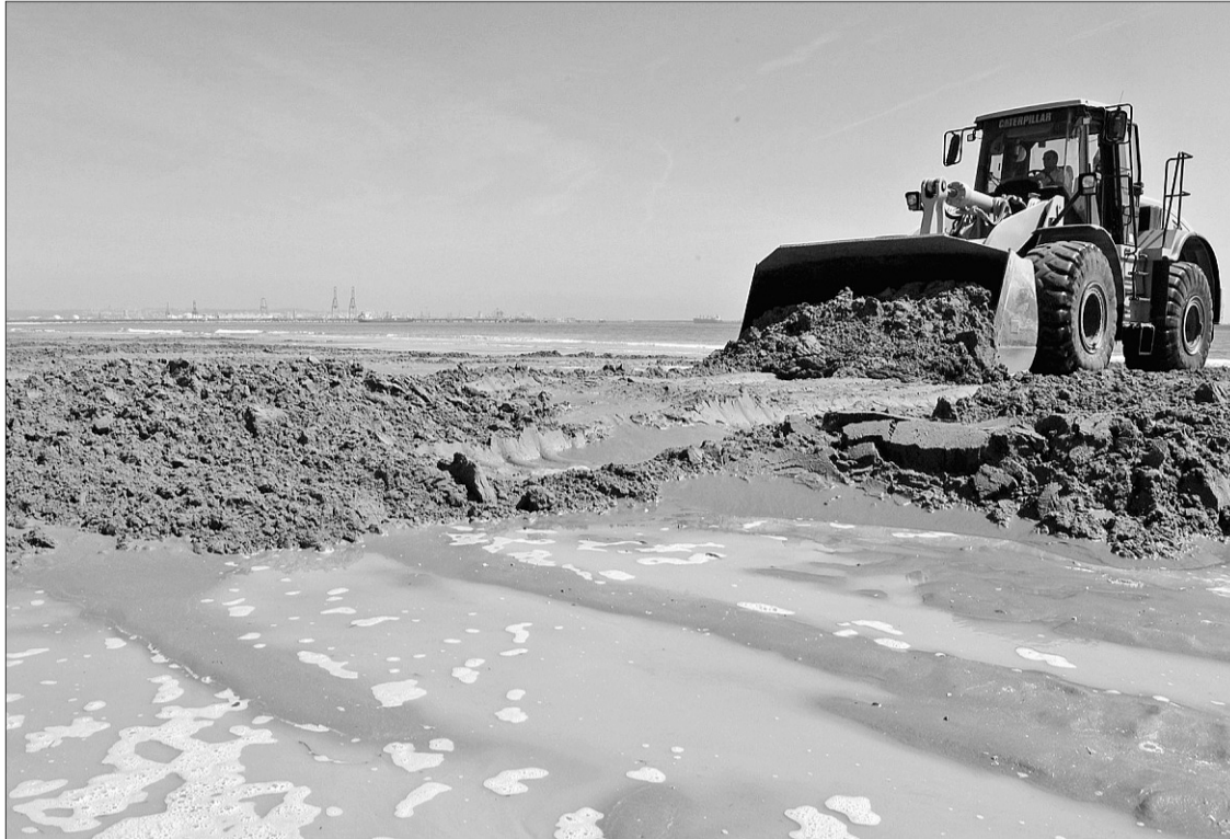
Una excavadora allana la arena que procede del fondo marino y que amplía la playa de La Pineda. FOTO: ALBA MARINÉ
